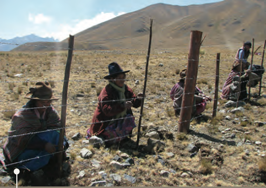
Miembros de la comunidad instalando cercas
